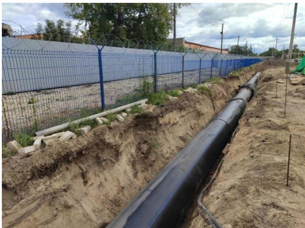
**Фото 7.** Укладка полиэтиленовых труб, диаметром 1000\*59,3 мм (участок от шоссе Речное (проектируемая КНС 101/3) до шоссе Речное, д. 31(до точки подключения к коллекторам К1№1 и К1№3).
