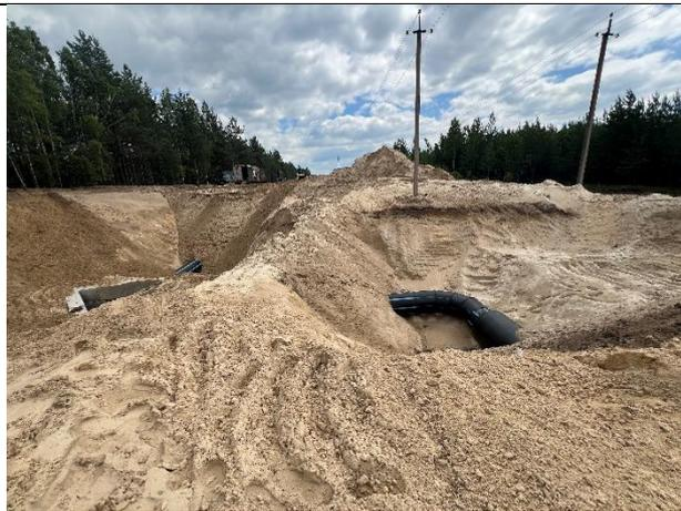
**Фото 4.** Забетонированные упоры на углах поворота УП30, УП31 (участок от площадки ТВ3 до перехода М7).
