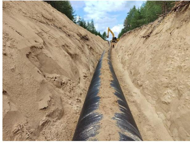
**Фото 5.** Укладка трубопровода из полиэтиленовых труб диаметром 900\*53,3 мм в траншею (участок от площадки ТВ3 до перехода М7).
