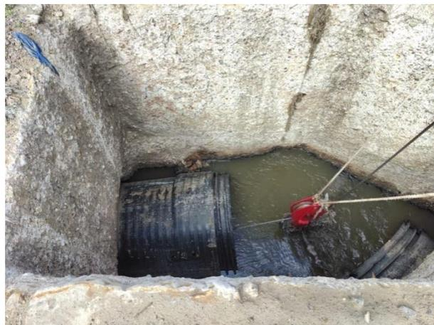
**Фото 8.** Работы по санации существующего коллектора по ул. Автомобильной (участок от пл. Привокзальной д. 2(КК-8-15) до ул. Октябрьской 86а (КК-18-948г).
