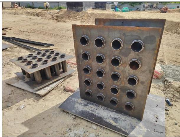
**Фото 12.** Изготовление трубных решеток под кабели (КНС).
