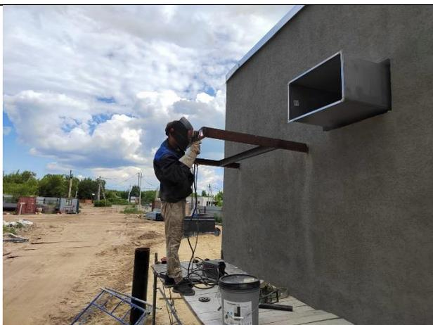
**Фото 9.** Монтаж площадок для монтажа вентиляционных каналов (КНС).
