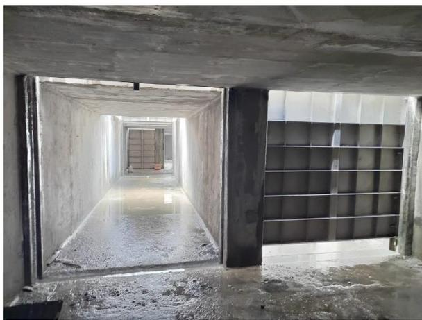
**Фото 6.** Бетонирование боковых стен затворов в камере решеток безусадочной смесью (КНС).
