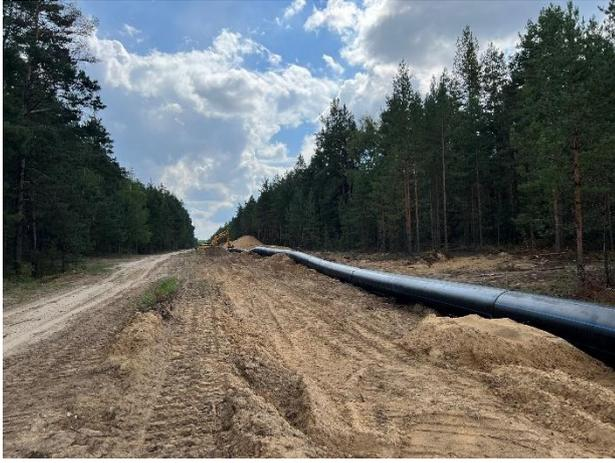
**Фото 4.** Сваренная плеть трубопровода из полиэтиленовых труб диаметром 900\*53,3 мм (участок от площадки ТВ3 до перехода М7).
