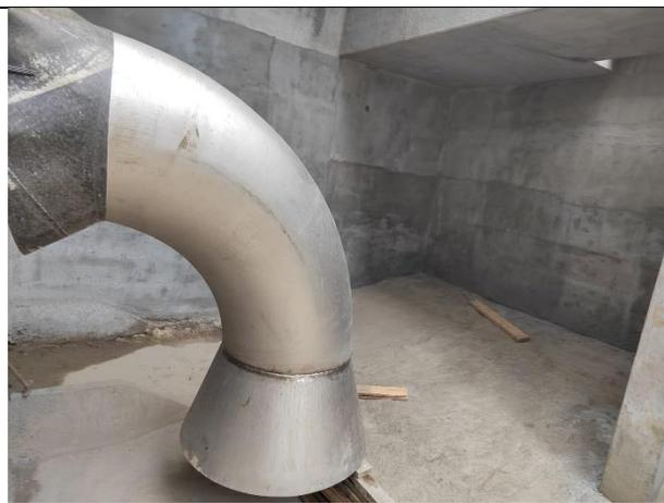
**Фото 10.** Монтаж всасывающего трубопровода в канале стоков (КНС).
