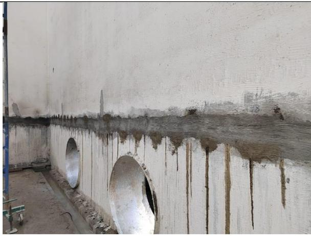
**Фото 2.** Устранение запотевания шва на отм.3.100 машинный зал (КНС).
