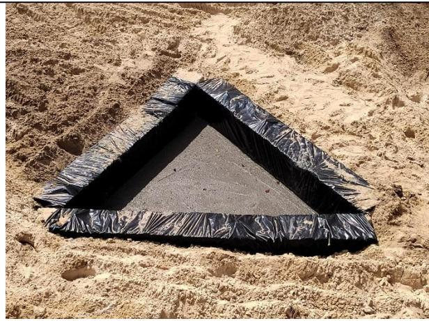
**Фото 9.** Забетонированы упоры на углах поворота УП28, УП29 (участок от площадки ТВ3 до перехода М7).
