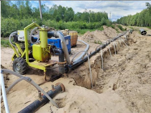
**Фото 6.** Работы по понижению грунтовых вод иглофильтровальными установками на участке сети от ВК13 до ВК14 (участок от площадки ТВ3 до перехода М7).
