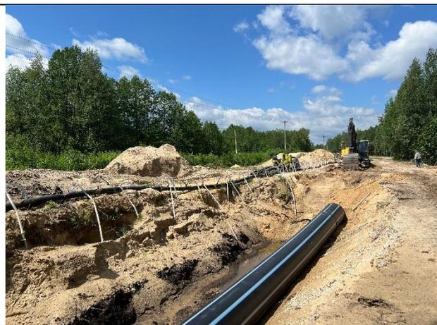
**Фото 1.** Работы по понижению грунтовых вод иглофильтровальными установками на участке сети от ВК13 до ВК14. (участок от площадки ТВ3 до перехода М7).
