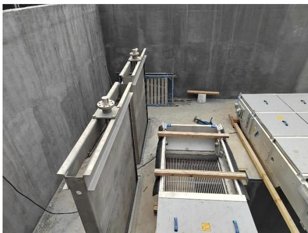
**Фото 4.** Пуско-наладка затворов VAG + электроприводов Аума (шеф-монтаж) (КНС).
