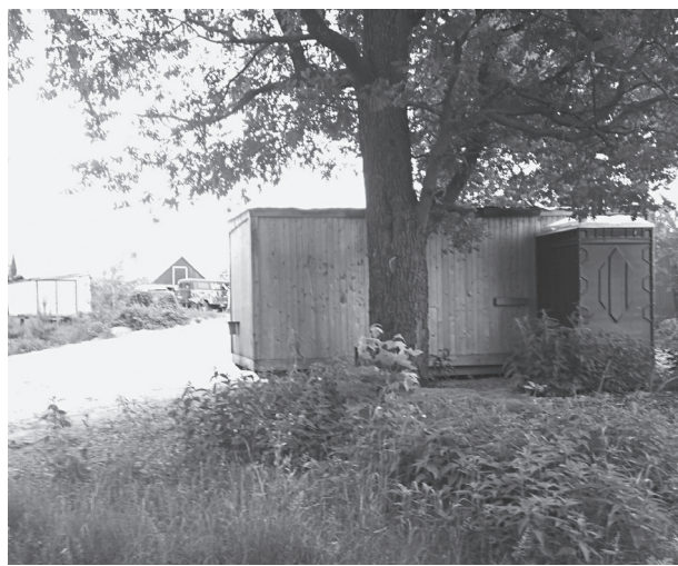
На берегу озера уже начались строительные работы
